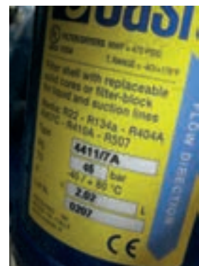
Fig. c - Filtro deidratatore Dryer filter
