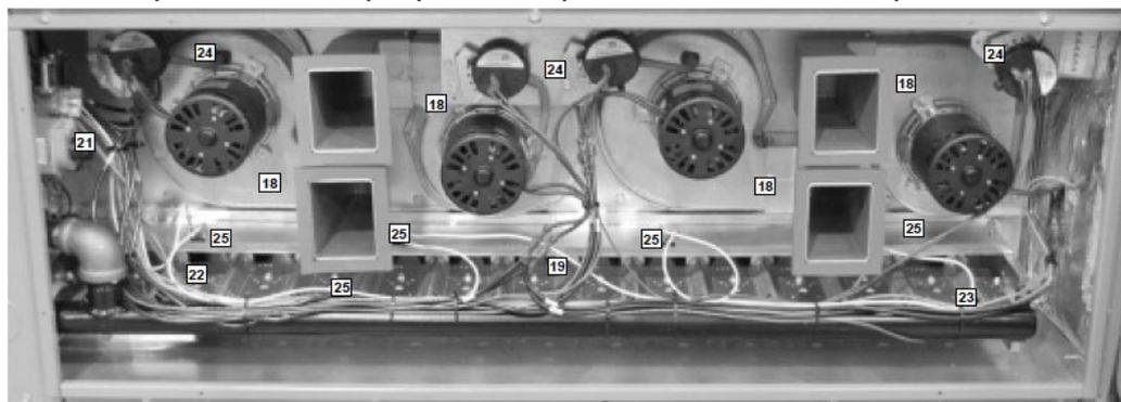
Aprinderea directă cu scânteie, 22, asigură aprinderea combustibilului în cele mai grele condiții. Aprinderea este cuplată cu un senzor de flacără, 23, pentru a se controla ca flacăra să se dezvolte în întreg volumul camerei de ardere. Conexiunea la alimentarea cu gaz combustibil se poate realiza pe lateral sau prin șasiu.
