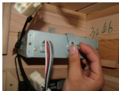
FIG-13.3 Aparafuse o suporte metálico
