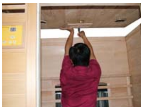
FIG-15 Conduza aos fios dos calefactores no painel através do furo correspondente
