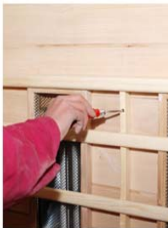
FIG-11 Monte a placa do assento
