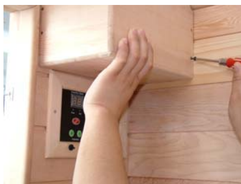
FIG-22.1 Fije la tapa con tornillos
