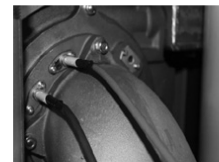
Tensiune ridicată în electrozii de ionizare și aprindere
