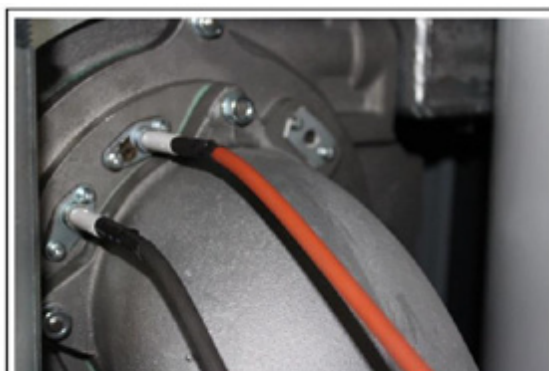
Electrozi de aprindere și ionizare
